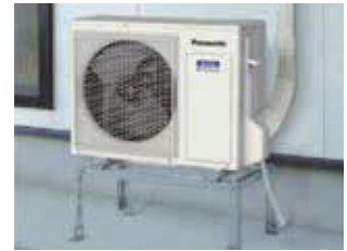
エアコン室外機架台
